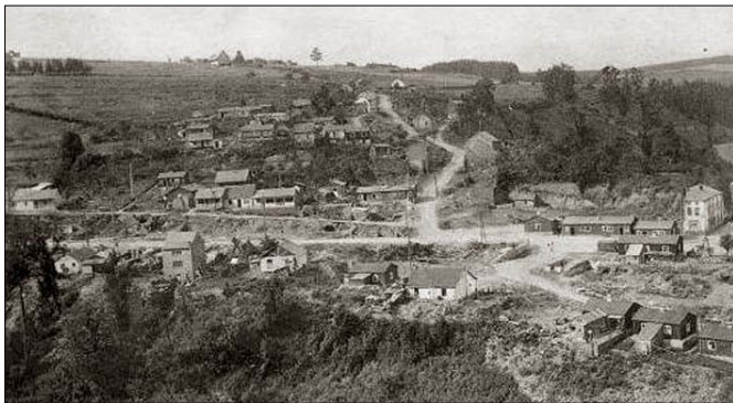
Houffalize vue de Sainte-Anne en 1946. Remarquez les nombreux baraquements faisant office de logements.
