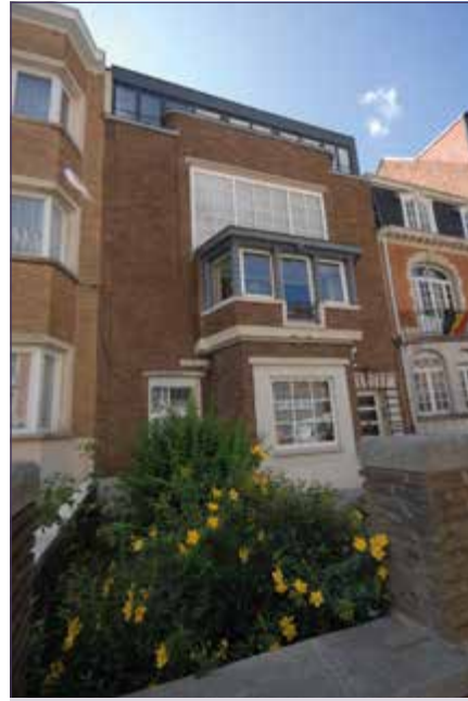
Façade de l'ancienne maison atelier du peintre Victor Gilsoul – vue actuelle
