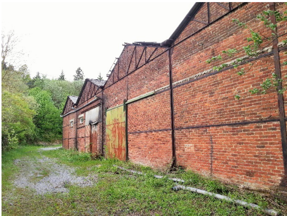
L'entrée latérale de l'annexe de la fonderie Libois par laquelle les réquisitionnés doivent pénétrer pour être triés par l'occupant (© SPW/Jacques Vandenbroucke).
