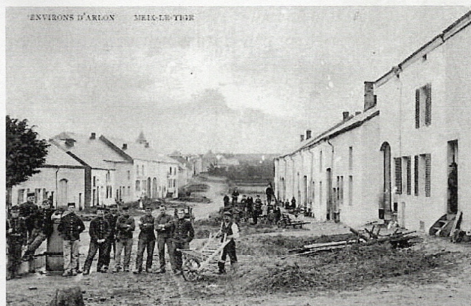
Rue du Monument
