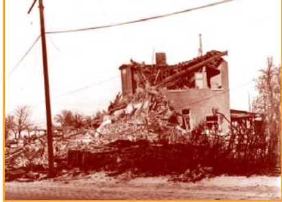
▲ Les terribles bombes V1 et V2 s'abattent sur nos contrées entre septembre 44 et janvier 45, tuant et détruisant irrémédiablement... Ici, Chaussée de Liège, coll. J. Moors.
