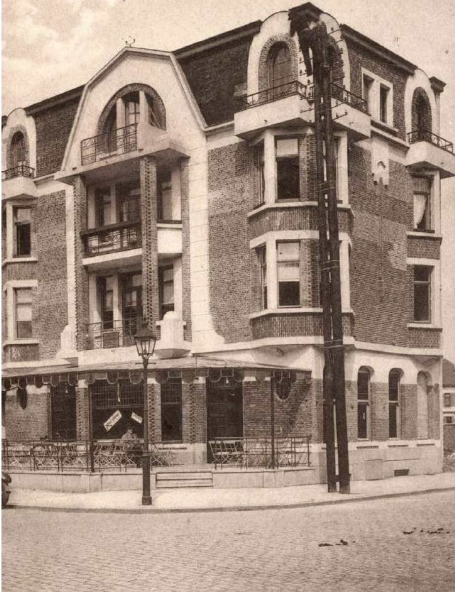
In dit huis op de hoek Boekenberglei-Cruyslei, woont het gezin Mandel-Mateles op een appartement. Jammer genoeg is het huis gesloopt en vervangen door een kantoor- en appartementencomplex.
