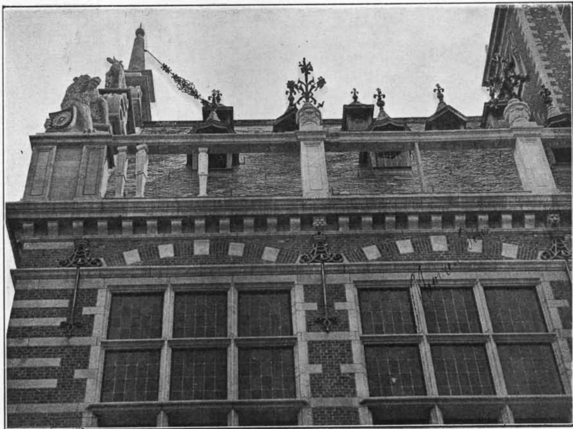
Vue de la façade montrant trois des balustres commandés par Mgr Ladeuze pour remplacer la balustrade ornementale dessinée par Whitney Warren. Trois des balustres seulement restent en place après la destruction opérée par la foule.
