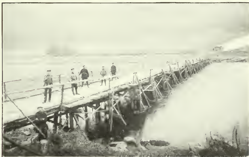
Fig. 9. — Le pont de bois construit par la 24 e division, XIX e corps, III e armée allemande, « au Colèbi », en regard de Lenne, pour le passage de la Meuse.
