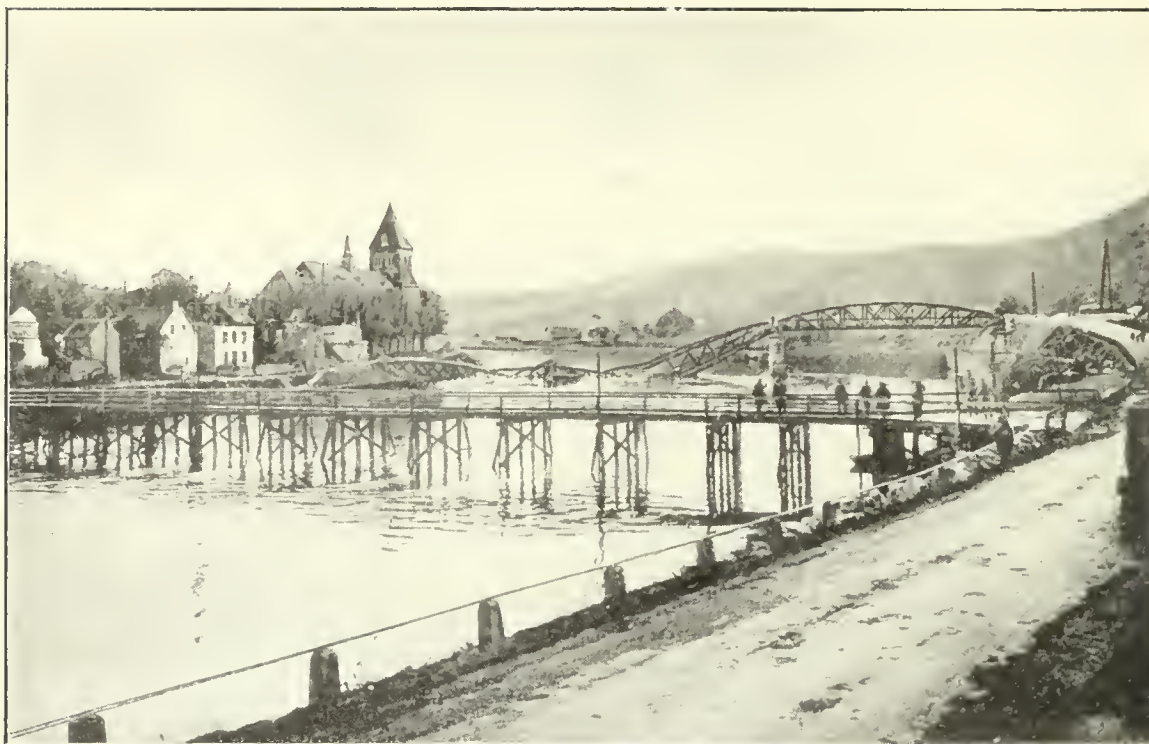
Fig. 10. — Hastière. Le pont de bois construit par le XIX e corps, III e armée allemande, pour le passage de la Meuse.
