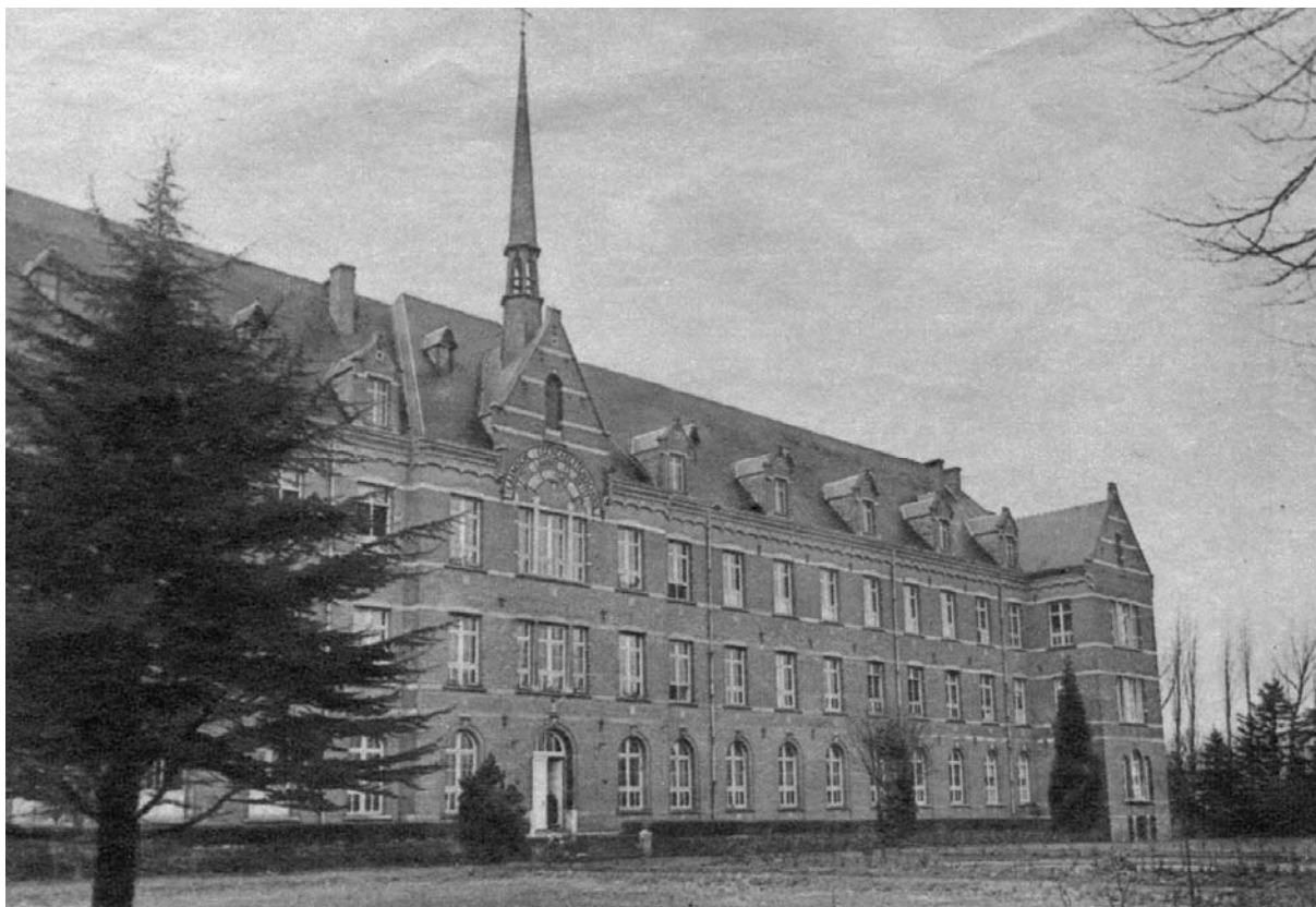
Figuur 48 : Vlaamse Cadettenschool te Saffraanberg Zicht op de voorgevel
